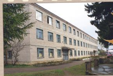
Главное административное здание Валдайского филиала государственного гидрологического института. В помещениях первого и второго этажей расположены служебные кабинеты Валдайского национального парка
