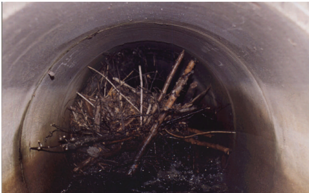
Фото 21. Костомукшский заповедник. Дорожная труба, перекрытая бобрами. Фото Ф.В. Фёдоров.
