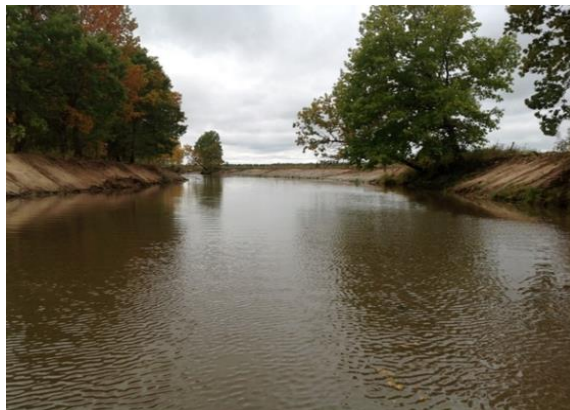
р.Полометь после проведения работ 1 этапа (2014-2016 гг.). Стоимость – 21 828,985 тыс.руб. Протяженность работ – 1,5 км
